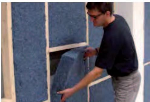
Les produits d'isolation Métisse® sous forme de panneaux ou rouleaux se posent conformément aux règles de l'art connues des professionnels du bâtiment.<sup>1</sup>
